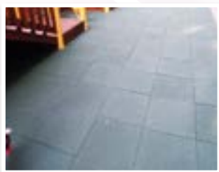
遊戲場汰換工 6
