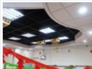
幼兒園整修工程 3
