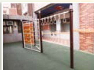
遊戲場汰換工 2
