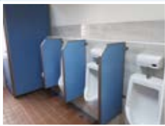
東側廁所整修 1
