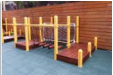
遊戲場汰換工 4
