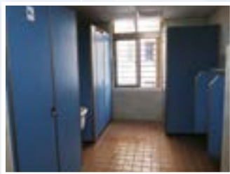
東側廁所整修 2
